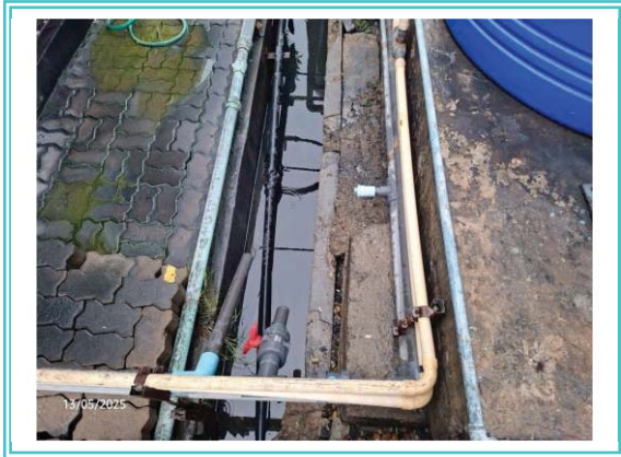
รูปที่ 3-7 รางระบายน้ำหักงอและอุดตัน
