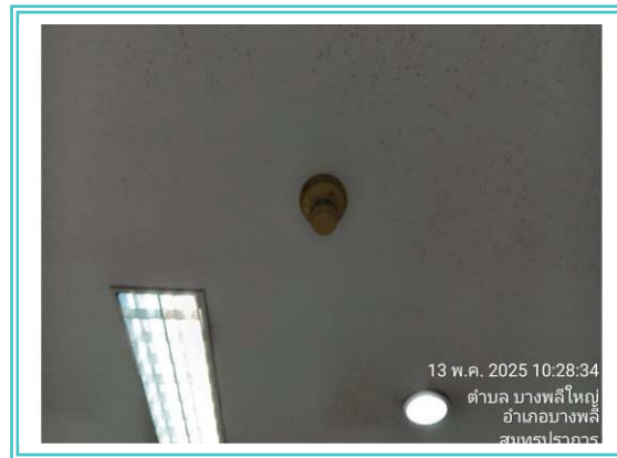
รูปที่ 3-33 ติดตั้ง Smoke Detector
