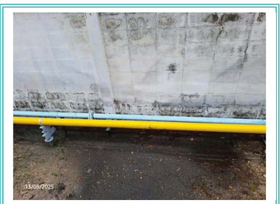
รูปที่ 3-15 ท่อส่งน้ำประปาภายในโรงงาน (สีฟ้า)
