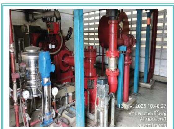
รูปที่ 3-31 ติดตั้งระบบบิมน้ำดับเพลิง
